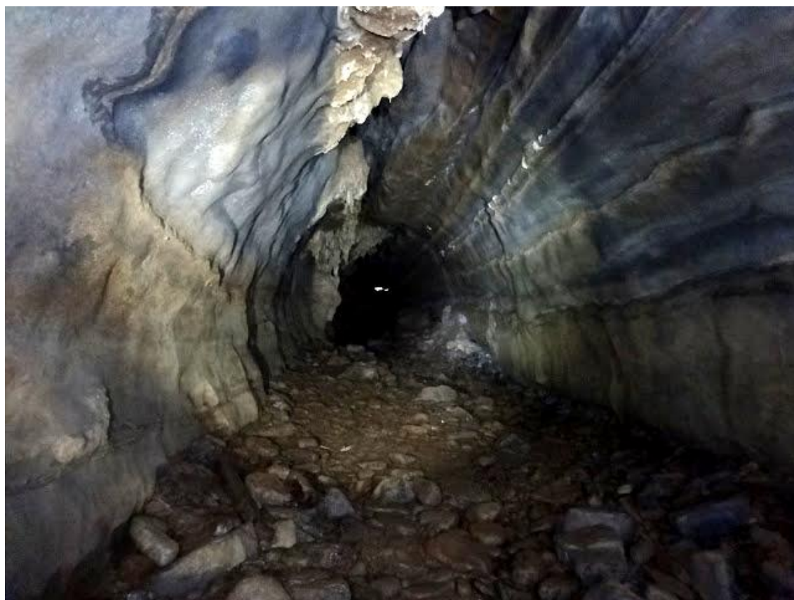
Figura 3.1-2. Conduto intermitente ("ladrão") do Córrego do Couto 46
