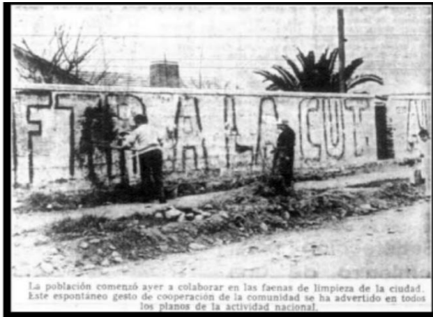
Figura 32: Muros e casas sendo pintados.
