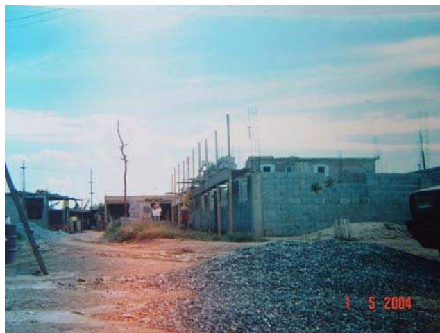
Figura 7 – imagem da construção da Igreja católica “Comunidade São José”
