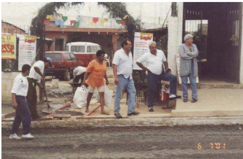
Figura 12 – trabalhos de pavimentação do programa Lote Legal, julho, 2001, em frente à Associação Portal II, na av. Arley Gilberto de Araújo, 61.
