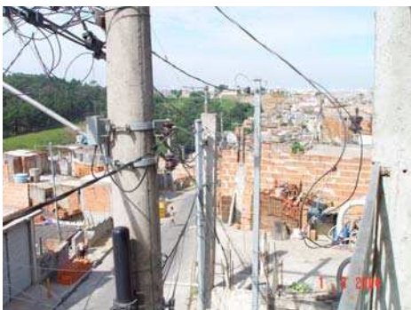
Figura 10 – vista de laje
