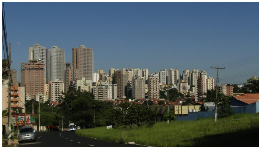
Figura 49 Vista Panorâmico do Bairro Jardim Botânico. Balão A.
