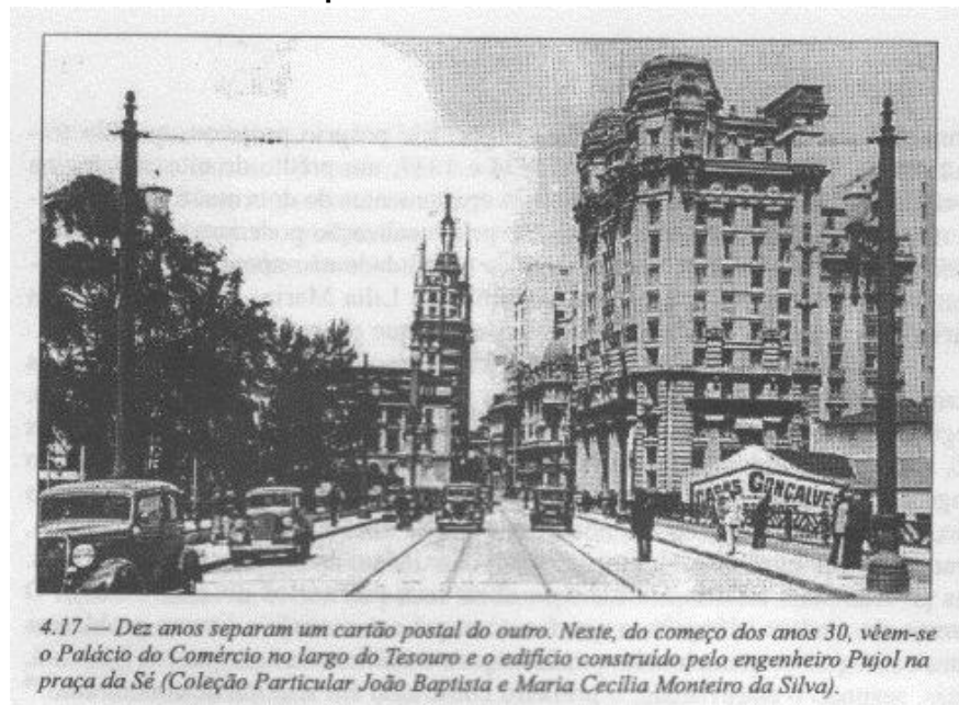
Figura 19 Vista de prédios do início dos anos 30
