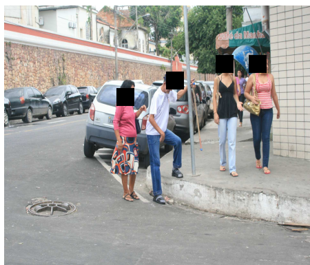
Imagem 14 – Degrau alto e desníveis. Rua Lobo da Almada.
