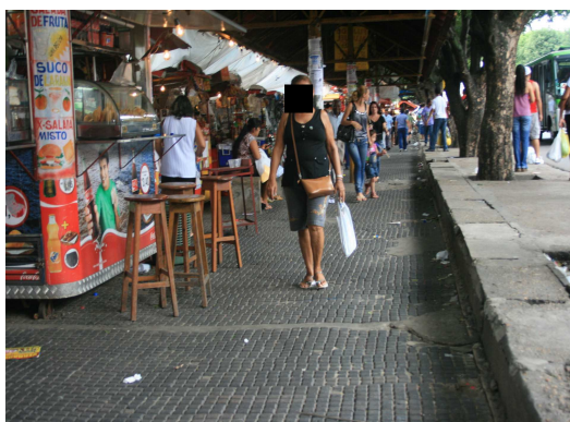
Imagem 17 – Desníveis na calçada. Praça da Matriz.
