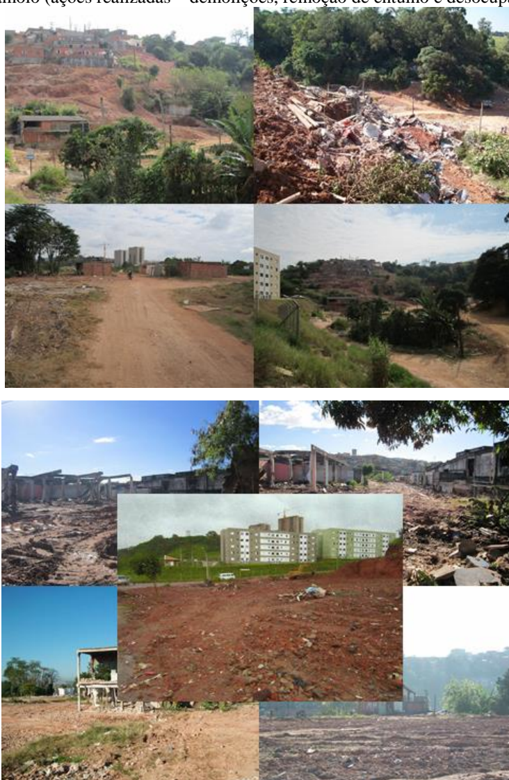
Figura 7 – Jardim Tamoio (ações realizadas – demolições, remoção de entulho e desocupação da área)
