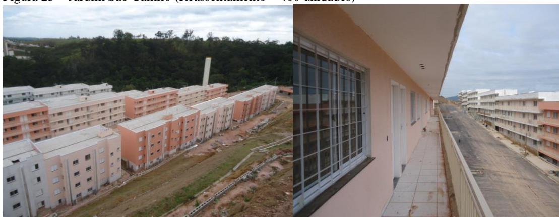
Figura 23 – Jardim São Camilo (Reassentamento – 400 unidades)
