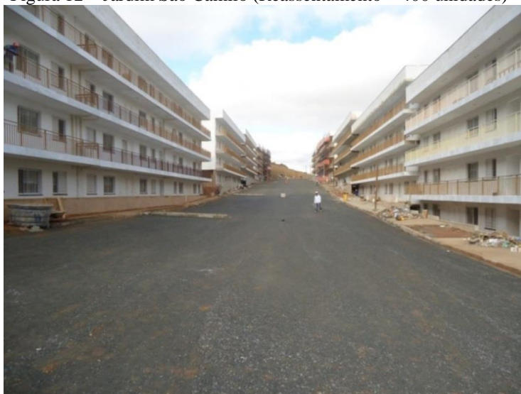
Figura 12 – Jardim São Camilo (Reassentamento – 400 unidades)
