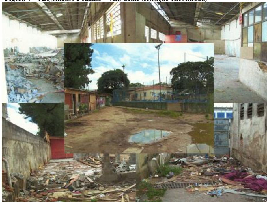
Figura 4 – Alojamento Pozzani - Vila Graff (situação encontrada)
