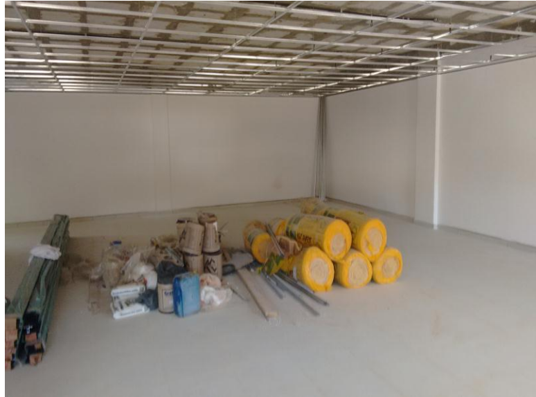
Figura 10– Obras do Laboratório de Inovação Acadêmica.
