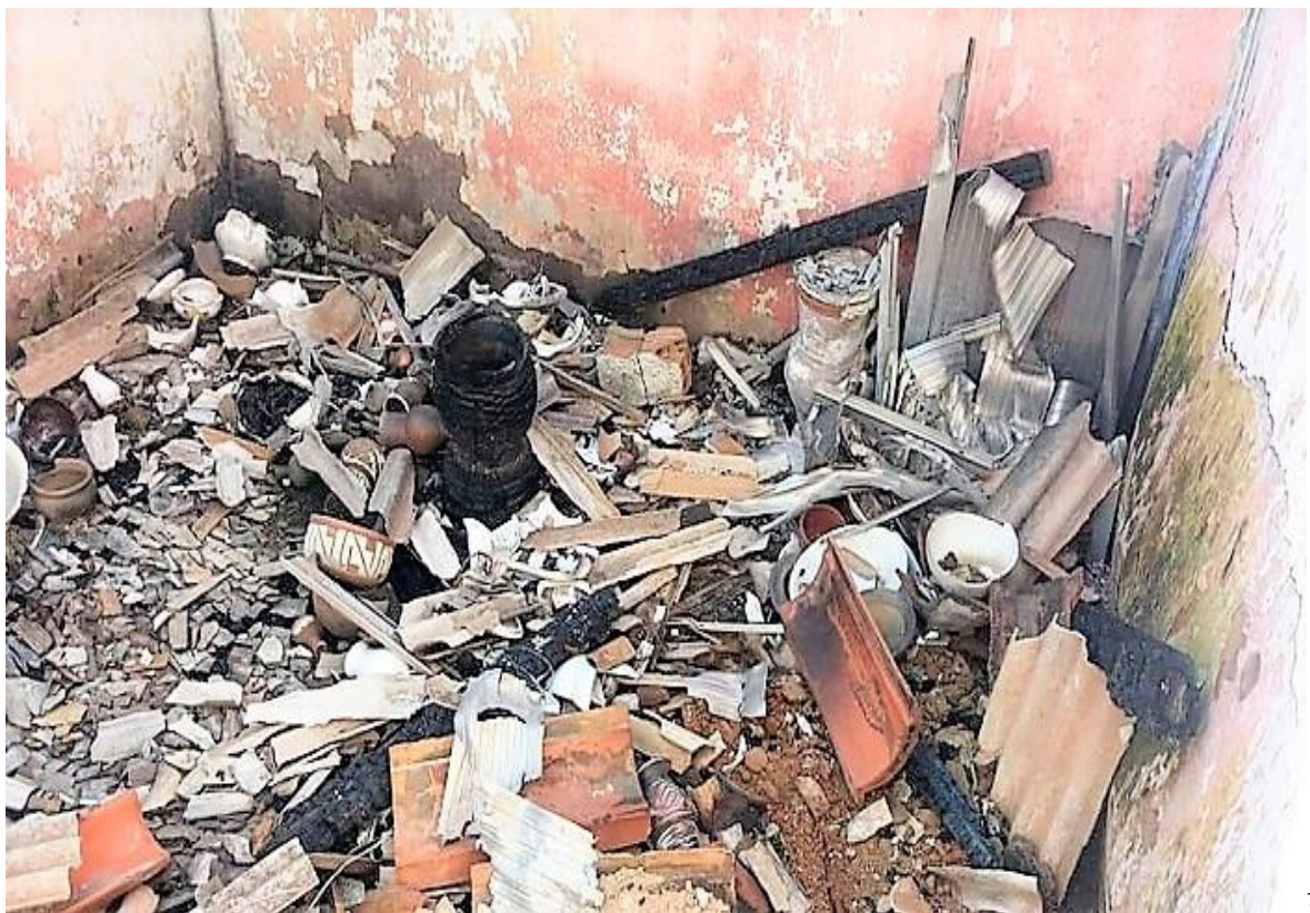
Figura 10 - Terreiro destruído na Baixada Fluminense (RJ)
