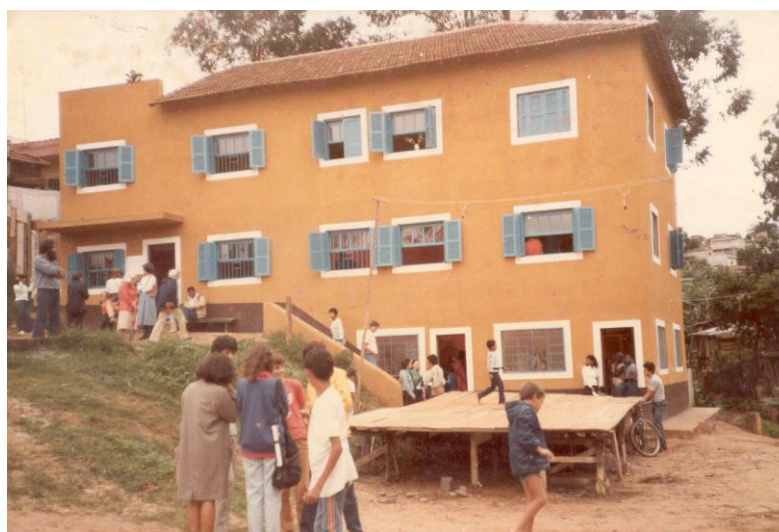
Figura 9 – Construção do Prédio do Ambulatório em 1985
