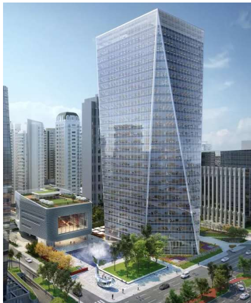
Figura 19 - Ilustração do Edifício Birmann 32
