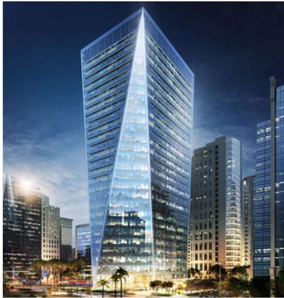
Figura 23 - Fachada Edifício B32
