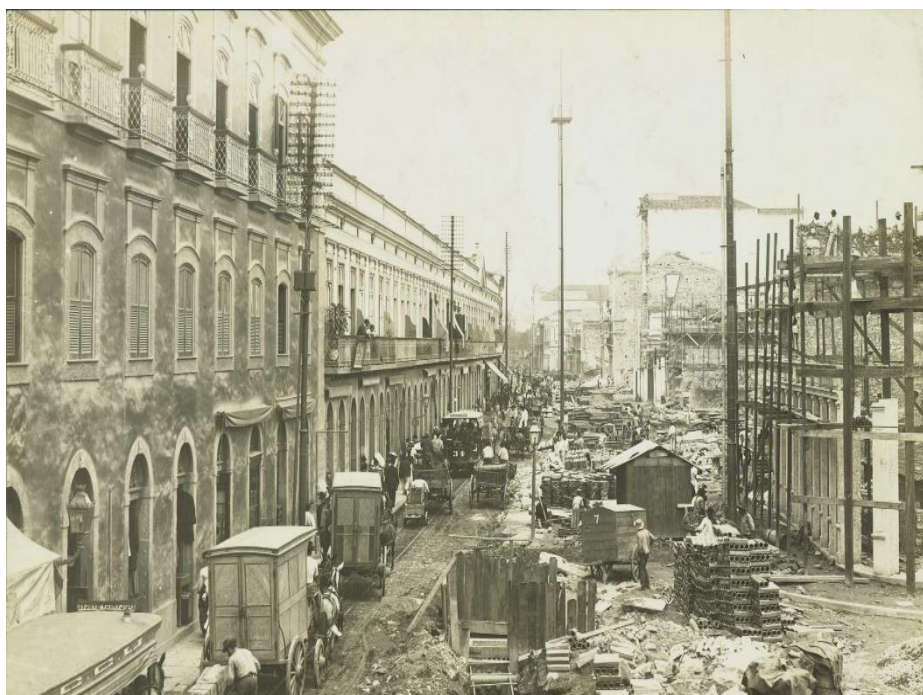
Figura 6 Rua da Carioca Abertura e alargamento das vias públicas para a construção de prédios e edifícios. Início do século XX Rio de Janeiro
