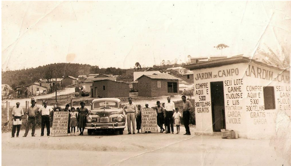
Figura 18: Venda de lotes nos anos 60 no Jardim do Campo, próximo ao "Campo do Guaianases" e a atual Av. Nordeste
